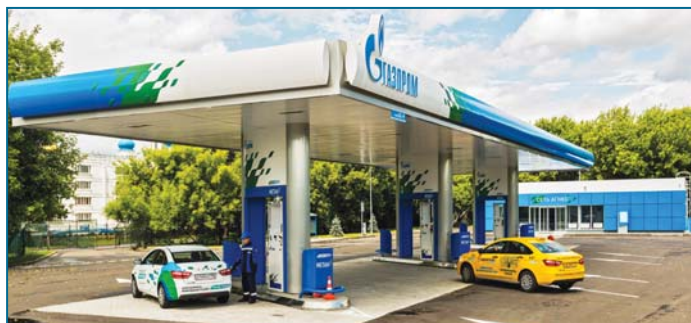
АГНКС «Газпром» на ул. Полбина в Москве
