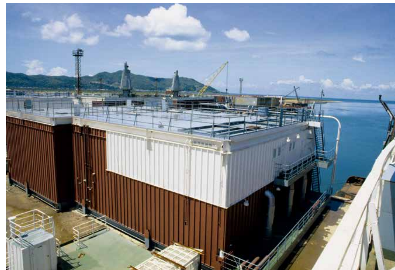
Секции верхнего строения для МСП ждут монтажа РИА «Новости»
