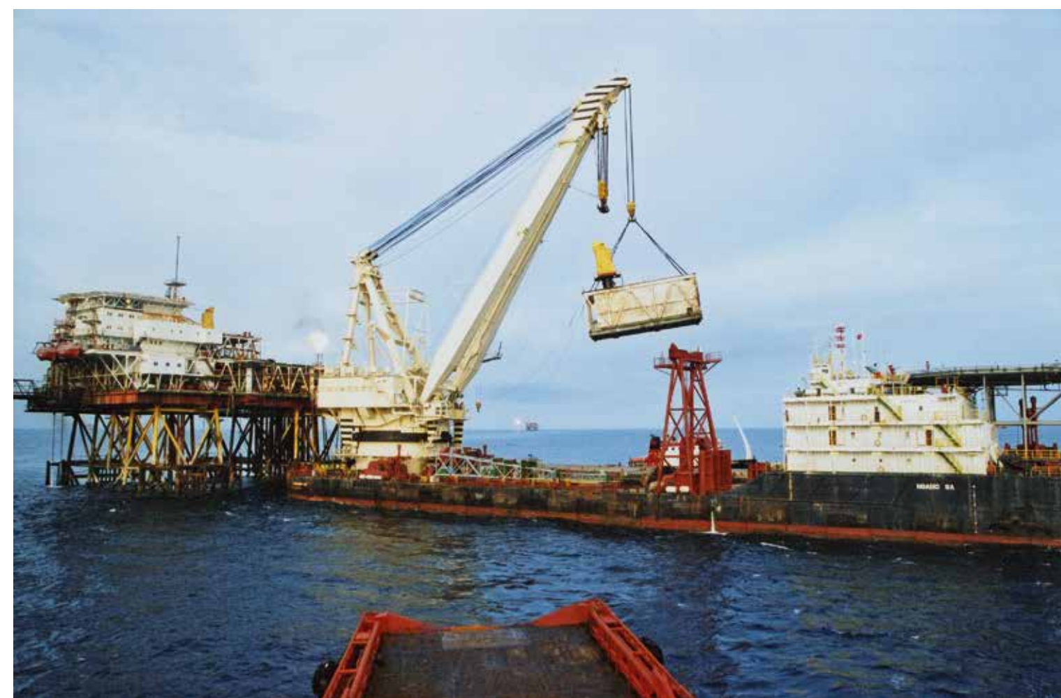
Перегрузка супер-блока плав-краном «Чыонгша» на МСП для дальнейшего монтажа
