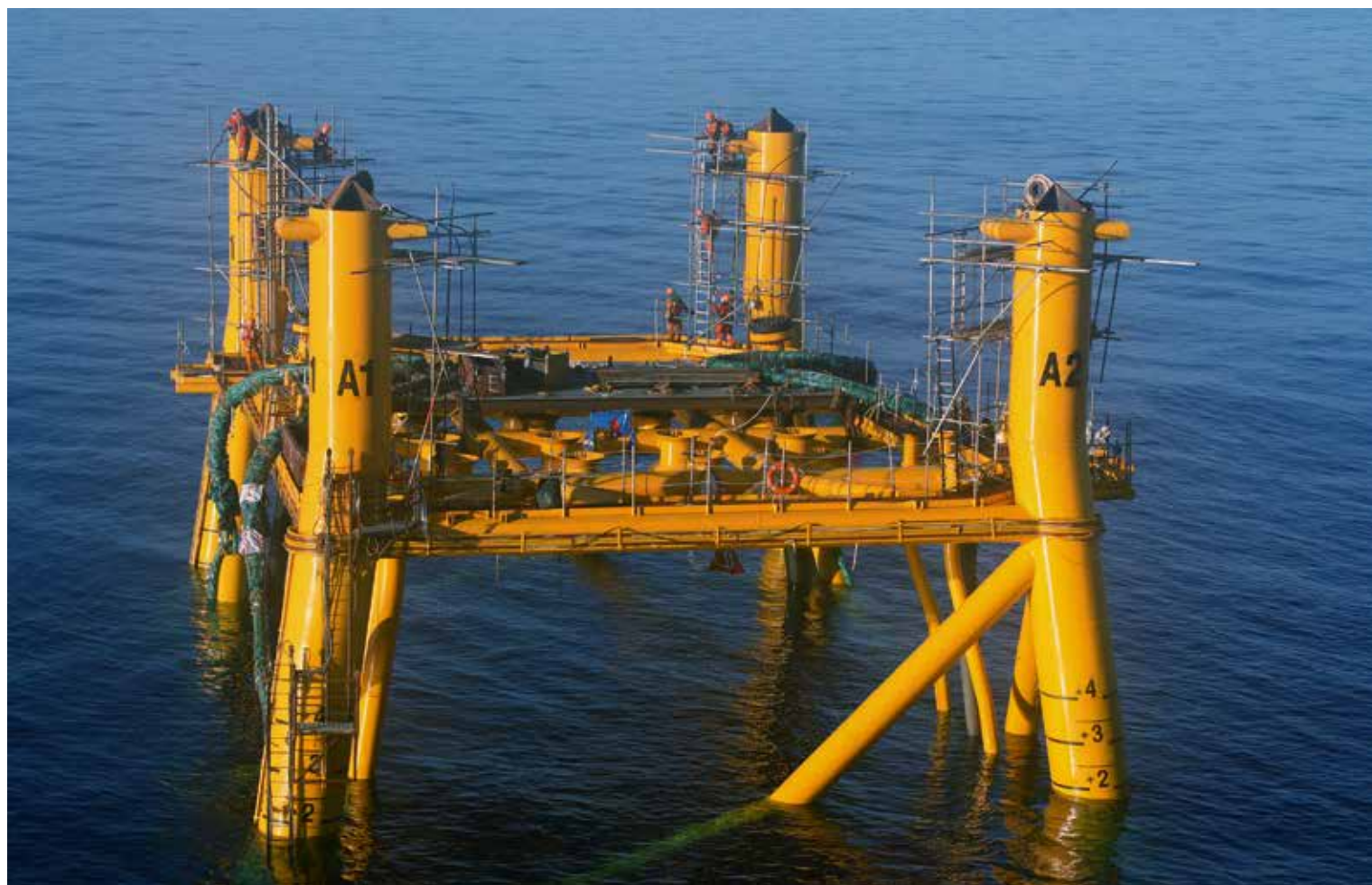
Опорный блок ждет установки верхнего строения платформы Мок Тинь
