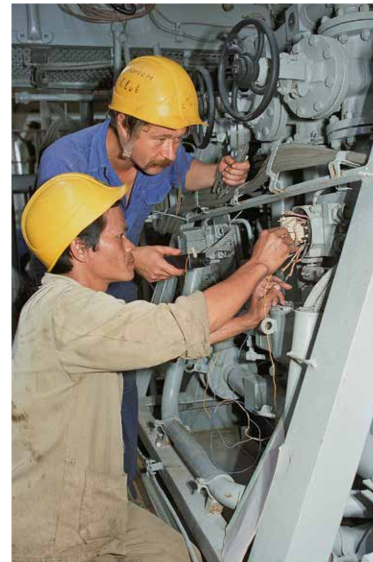
Слесари-ремонтники СП «Вьетсовпетро» РИА «Новости»
