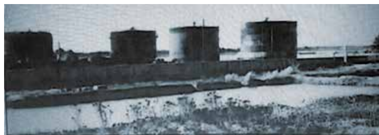
Резервуары нефтебазы в г. Вине
