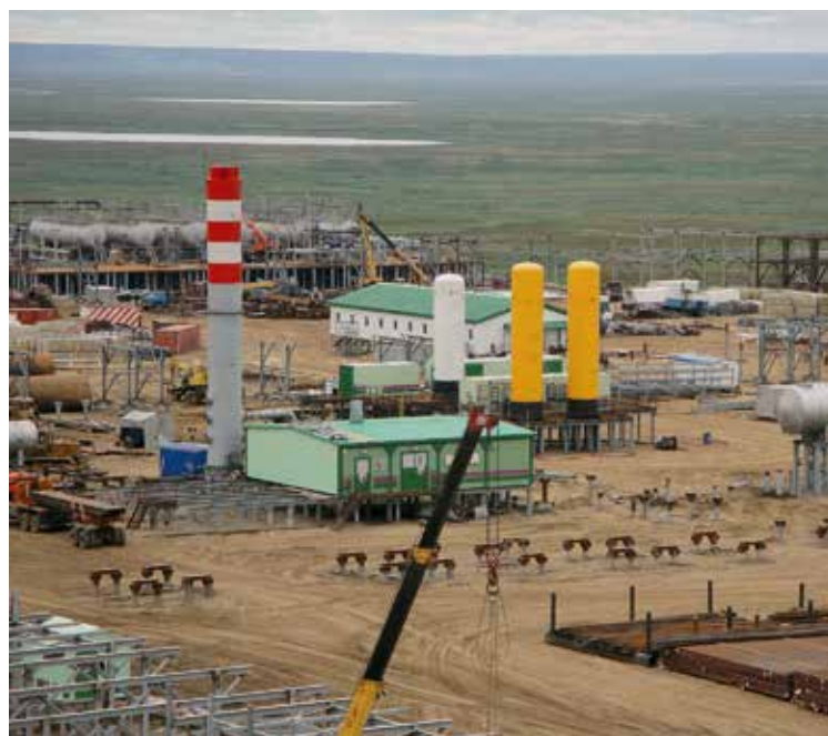
Начало работ на будущих нефтепромыслах СК «Русьветпетро». 2009 Архив ОАО «Зарубежнефть»
