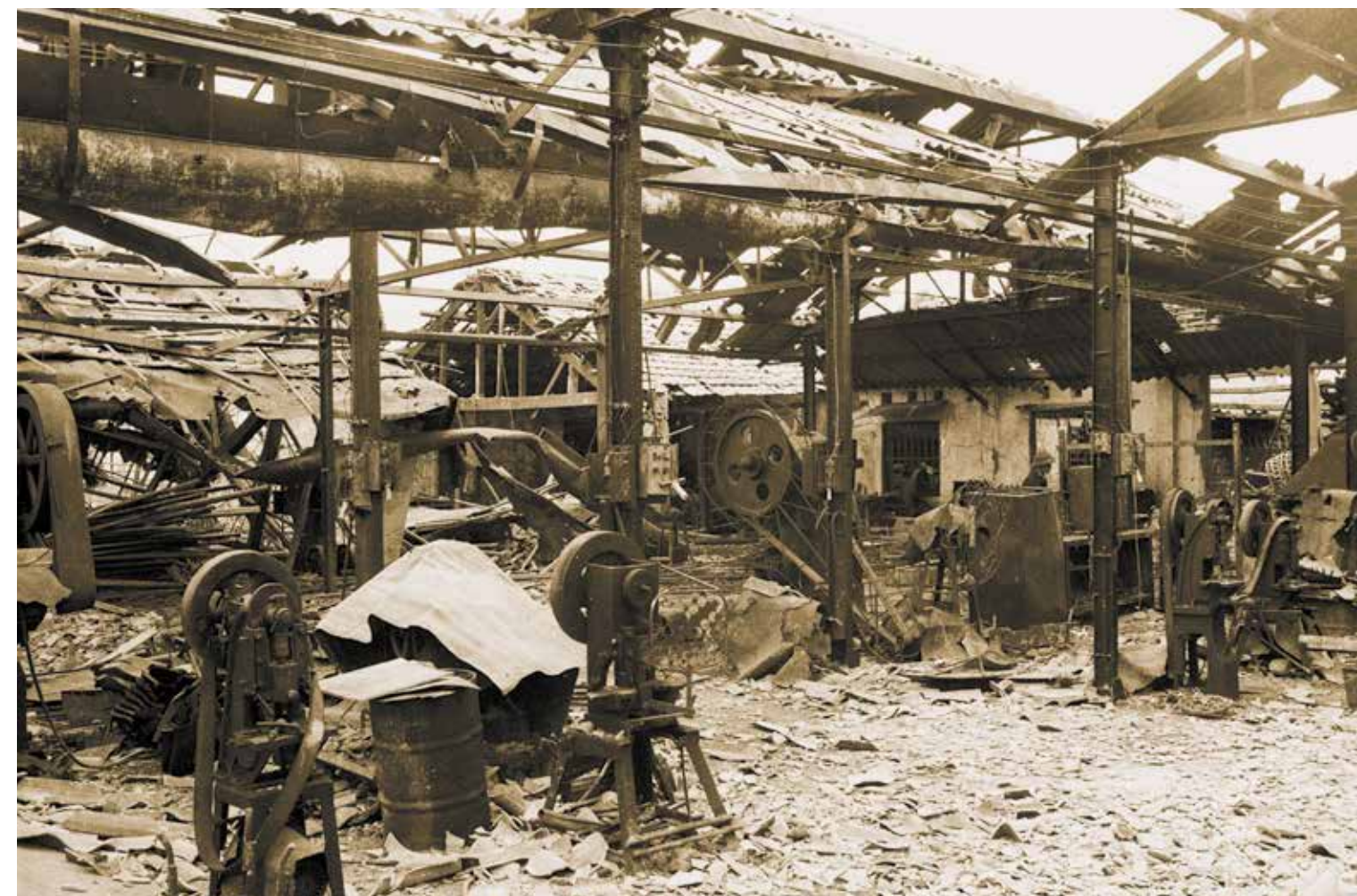
Разрушенная мастерская по ремонту сельхозоборудования под Ханоем РИА «Новости»
