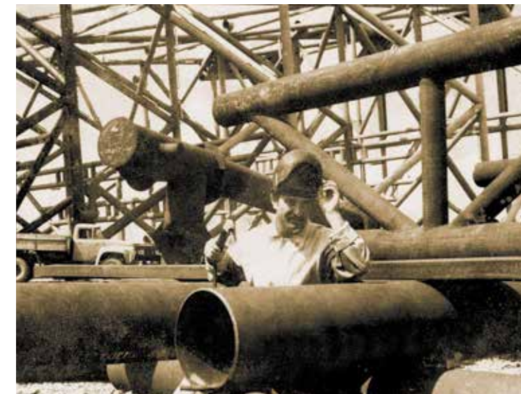
Идет сварка. 1983 Архив ГКНГ «Петровьетнам»
