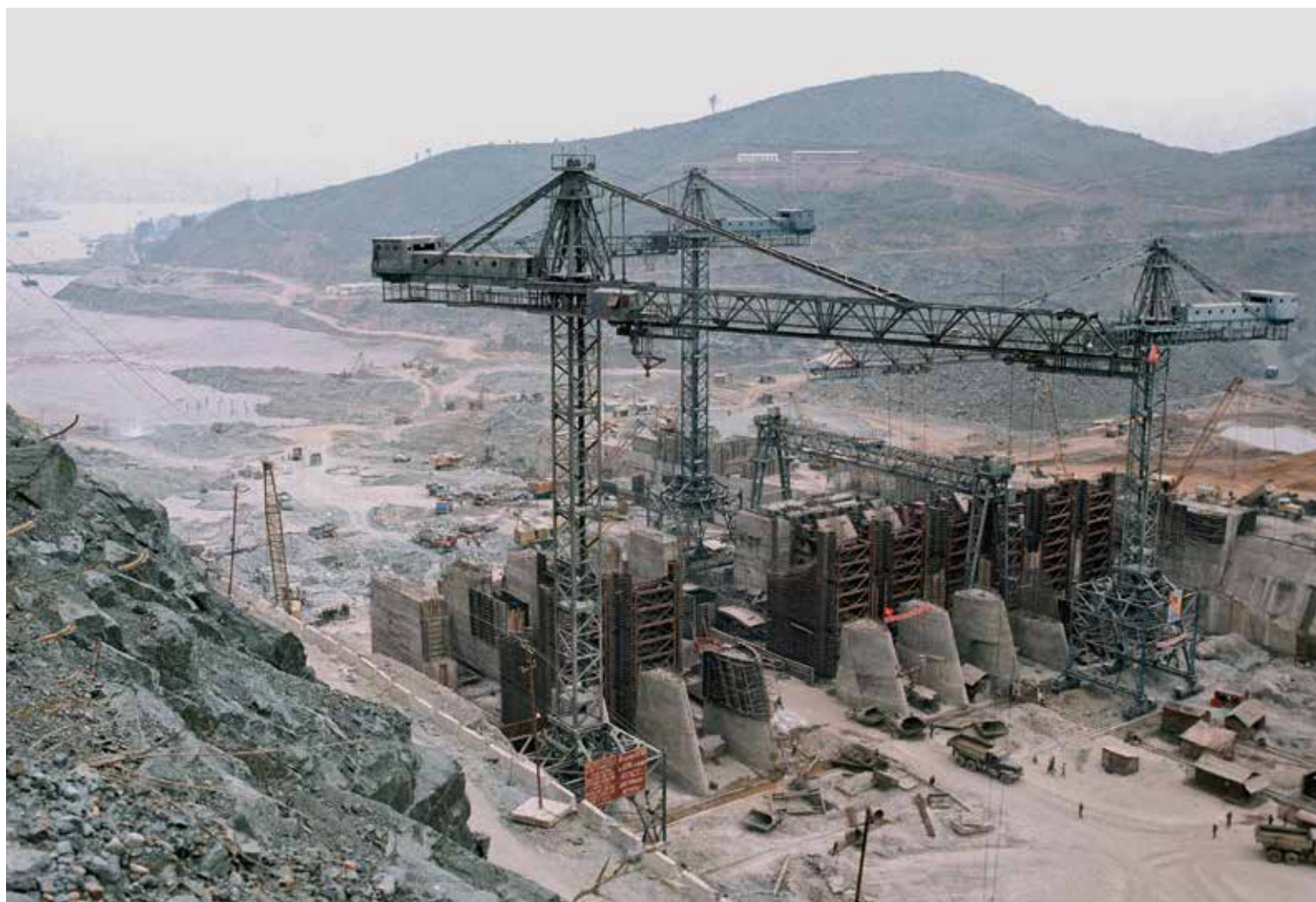
На строительстве ГЭС «Хоабинь». 1986 РИА «Новости»
