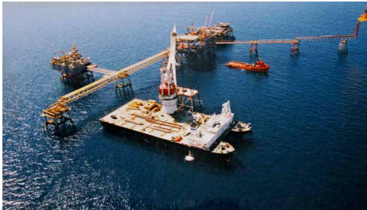
Крановое судно «Чыонгша» устанавливает жилой блок на ЦТП-2
