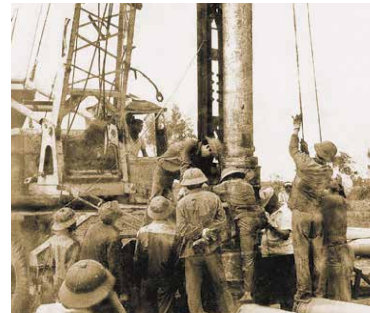
Строительство базы для обслуживания буровых станков Архив ГКНГ «Петровьетнам»
