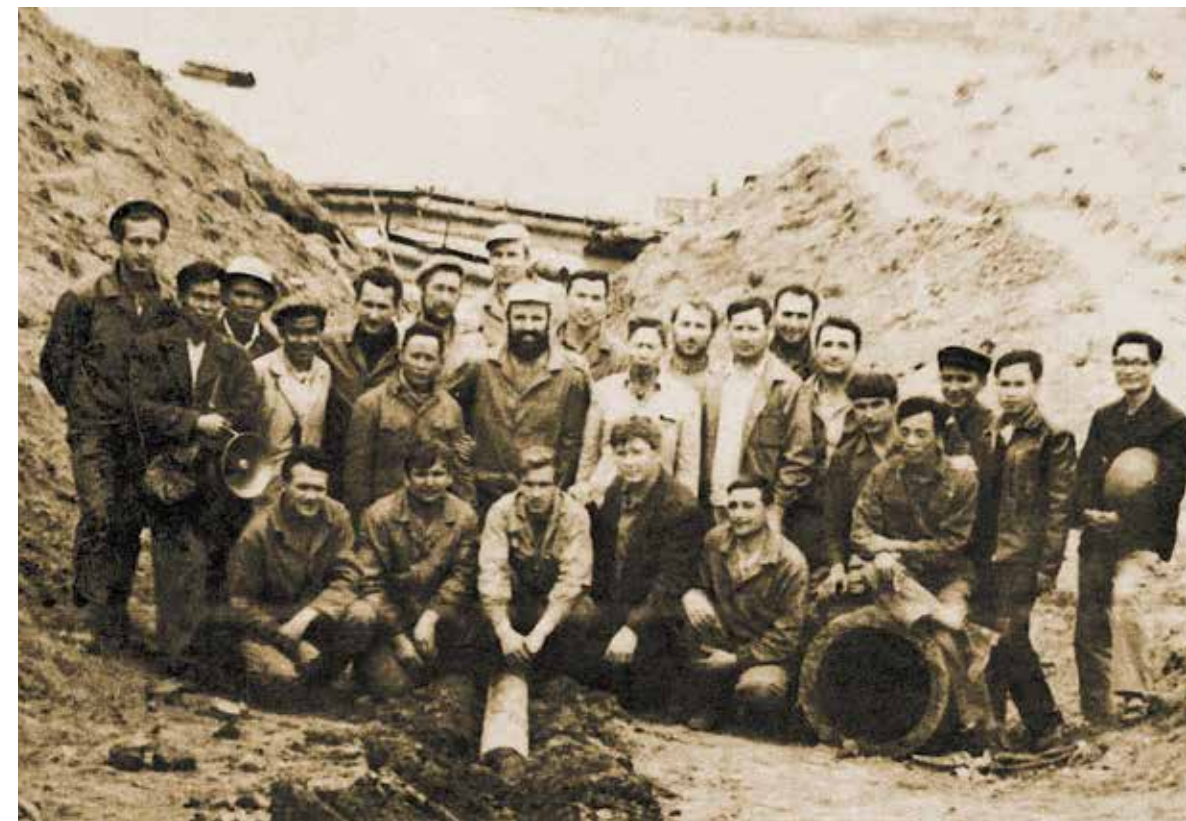
Советские и вьетнамские специалисты после успешного завершения строительства подводного перехода нефтепродуктопровода Байтяй — Фули через Красную реку. 1971 Архив Чыонг Динь Кыонга
