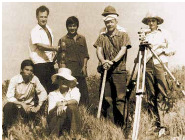
Изыскатели на трассе трубопровода
