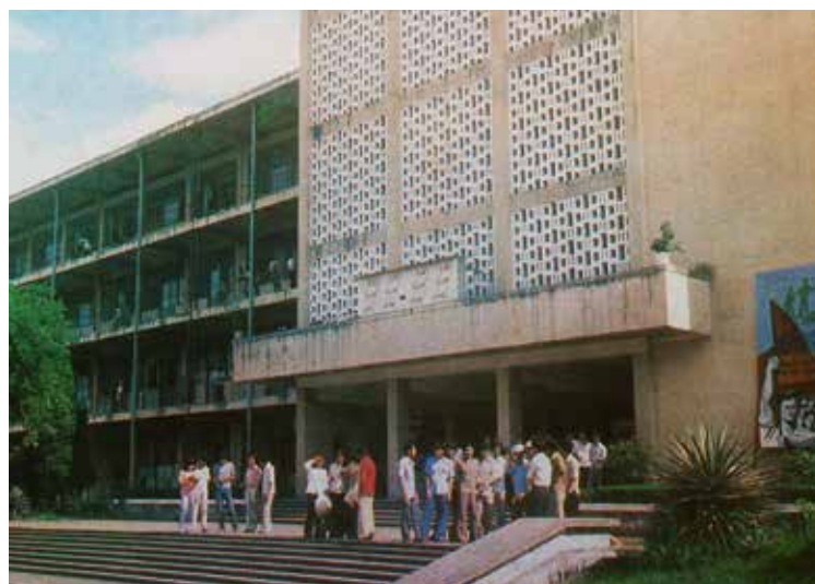
Ханойский политехнический институт
