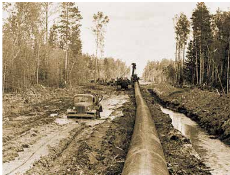
Строительство трубопровода в Сибири. 1960-е
