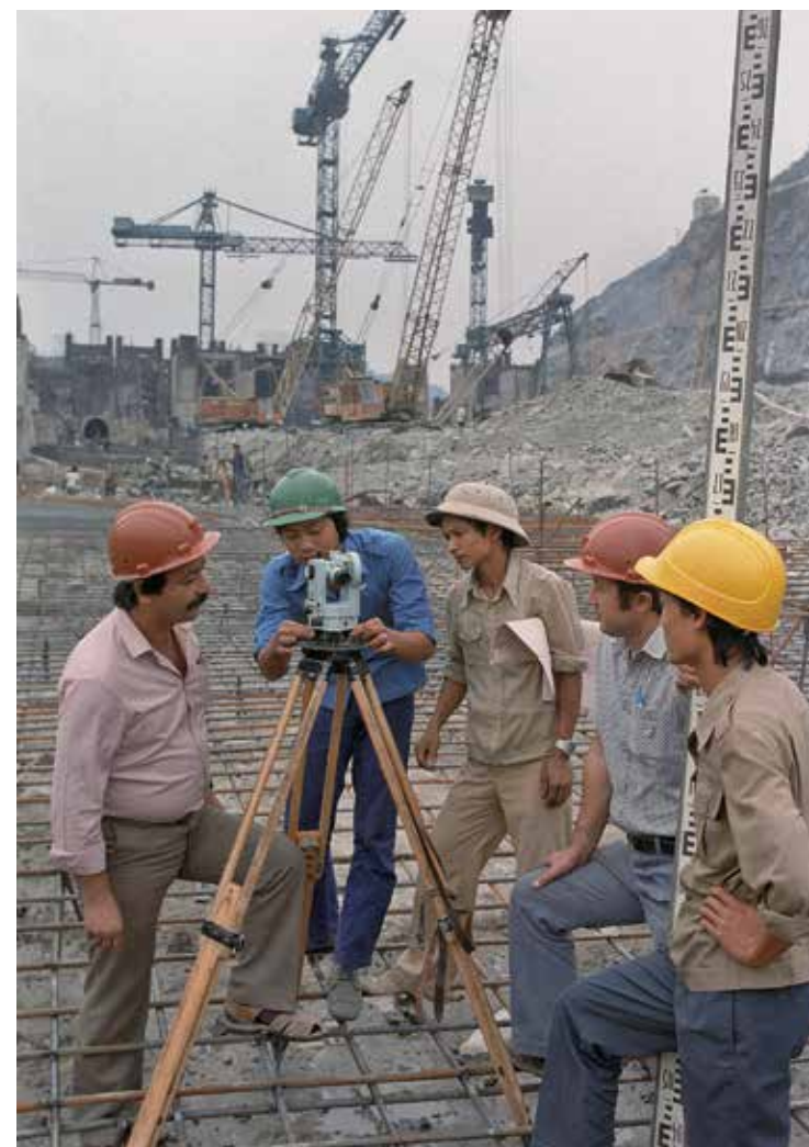
На строительстве гидроузла «Хоабинь». 1986 фото РИА «Новости»
