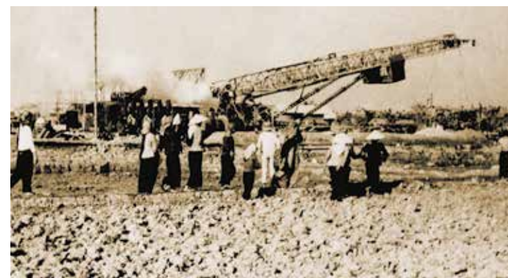
Установка вышки для бурения глубокой скважины Архив С. Г. Даумова
