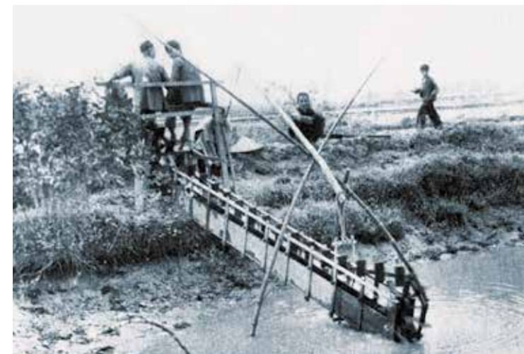
Ирригационные сооружения в местах работы геофизиков 36-й экспедиции в дельте Красной реки Архив М. Б. Шнеерсона
