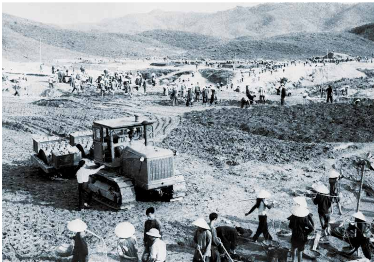
На строительной площадке РИА «Новости»
