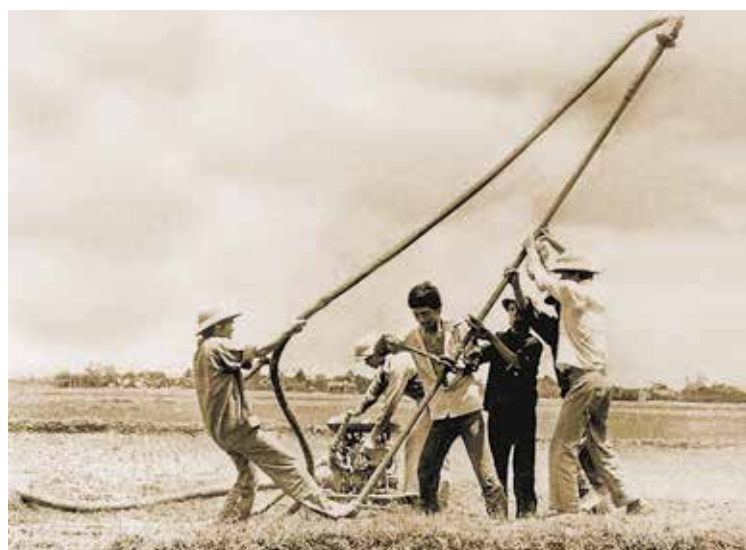
Подготовка к сейсморазведочным работам Архив ГКНГ «Петровьетнам»
