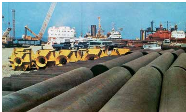
Узлы оборудования и трубы на площадке СП «Вьетсовпетро». 1987
