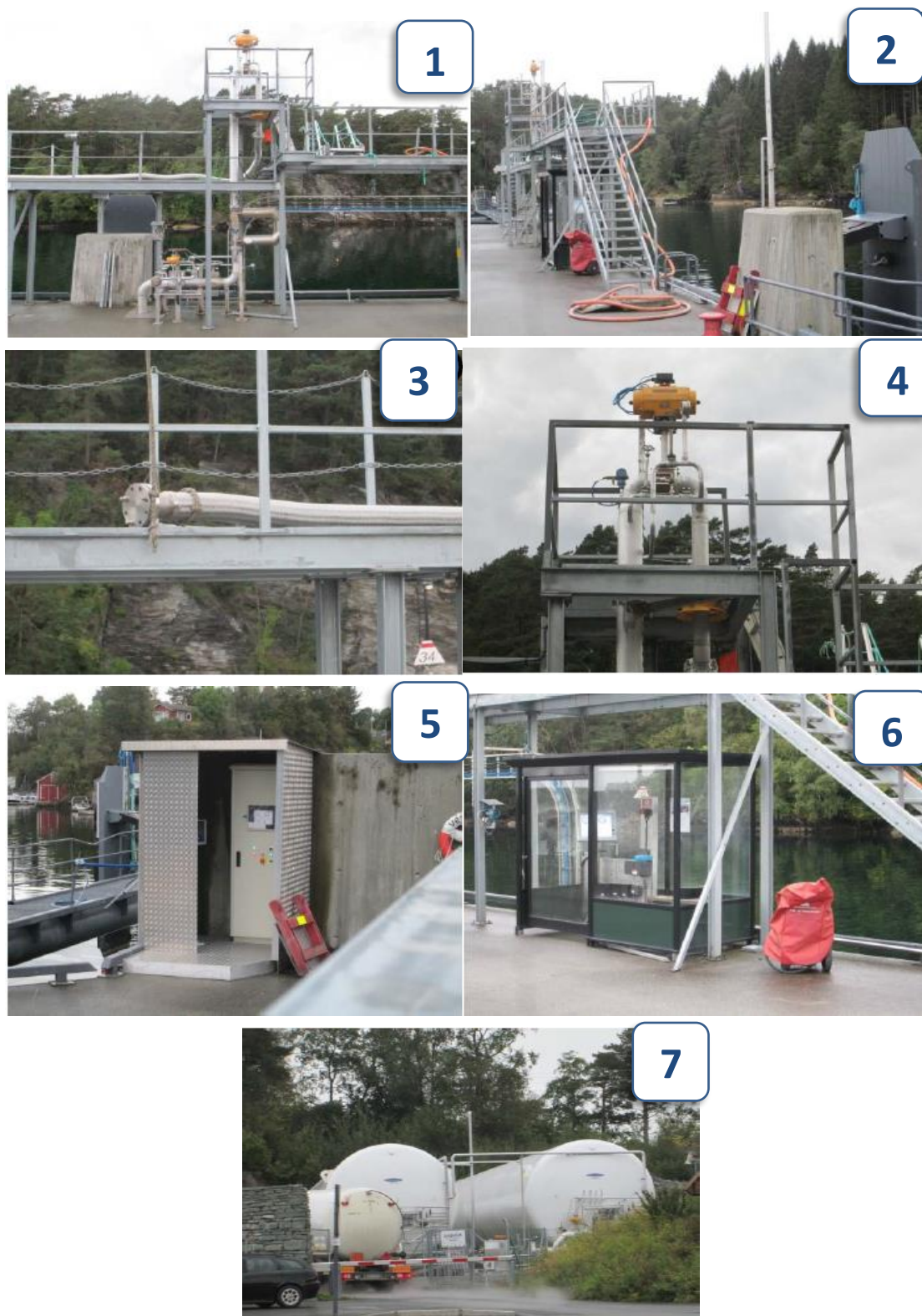
Рисунок 62: береговая база бункеровки автопассажирских паромов компании «Fjord 1» (Норвегия). 1-2) бункеровочный терминал; 3) криогенный шланг с фланцем, 4) счетчик СПГ; 5) пост управления бункеровкой; 6) пост учета выдачи СПГ; 7) хранилище СПГ (2 танка по 250 м 3 ).
